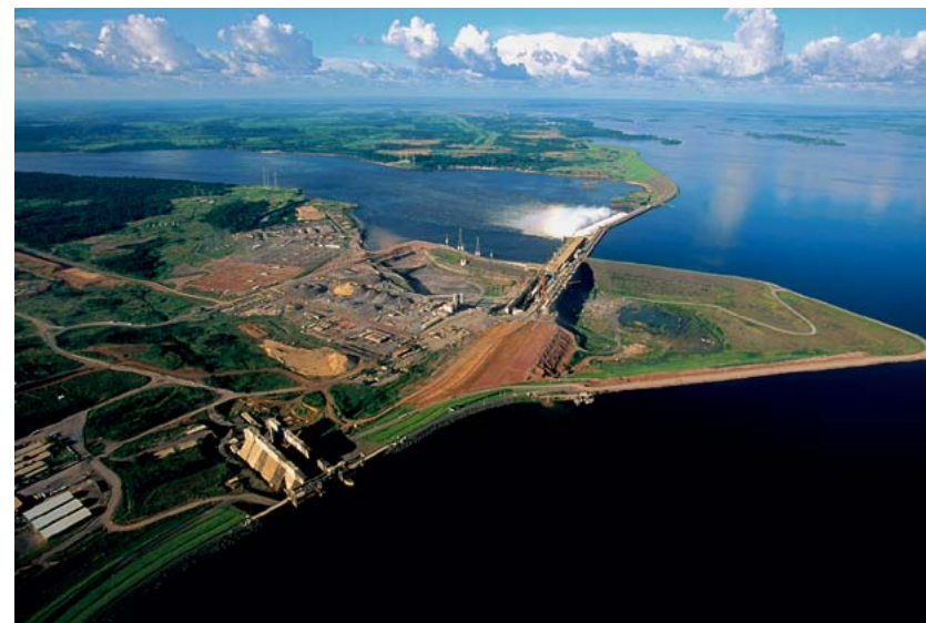
Hidroeléctrica de Tucuruí, río Tocantins, Pará, Brasil. © Paulo Santos, 2002
