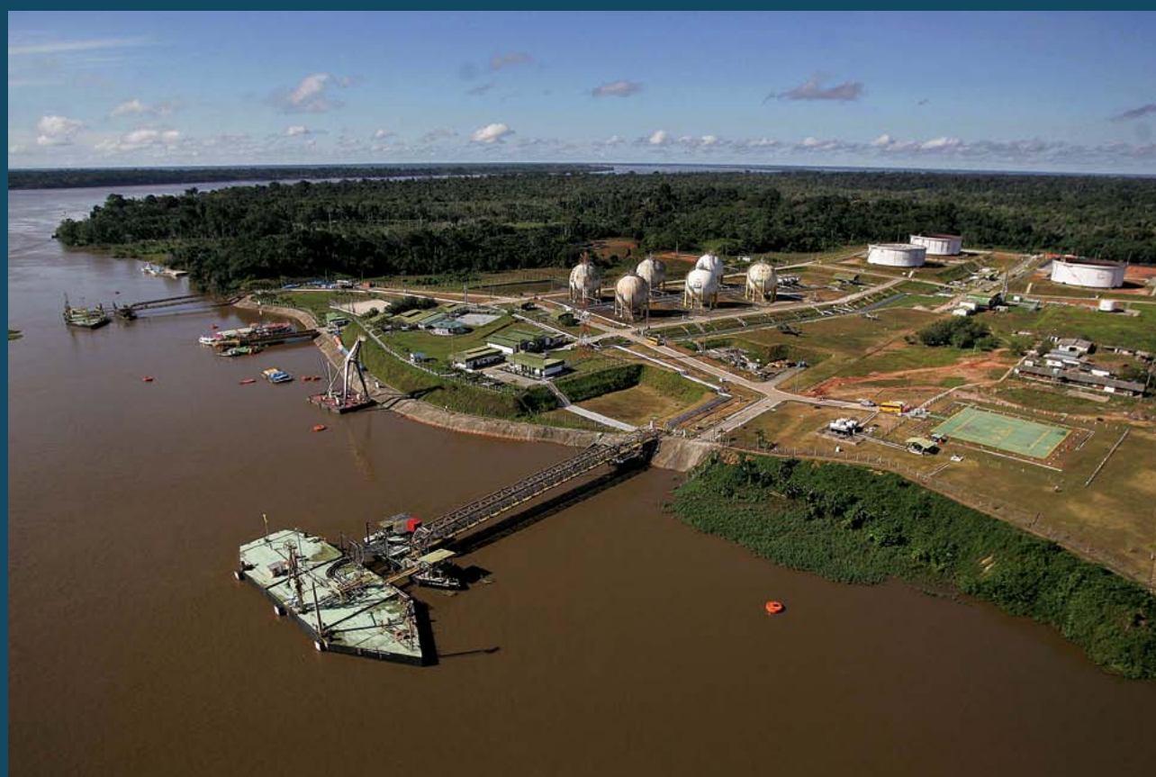
Terminal del gasoducto Uruçu de Petrobrás en Coari, Amazonas, Brasil. © Ricardo Stuckert, 2006
