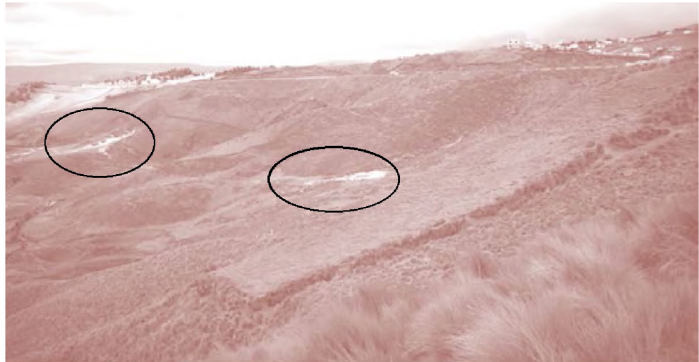
Foto 1: Erosión en Apahua
