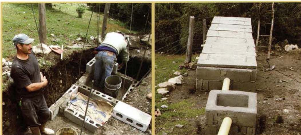
Fotos: Proceso de construcción, monitoreo y réplica de plantas piloto de tratamiento de aguas servidas residenciales.
