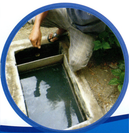
Trampa de grasas. Hostería La Terraza. Provincia de Manabí. ©Aves y Conservación, 2011.
